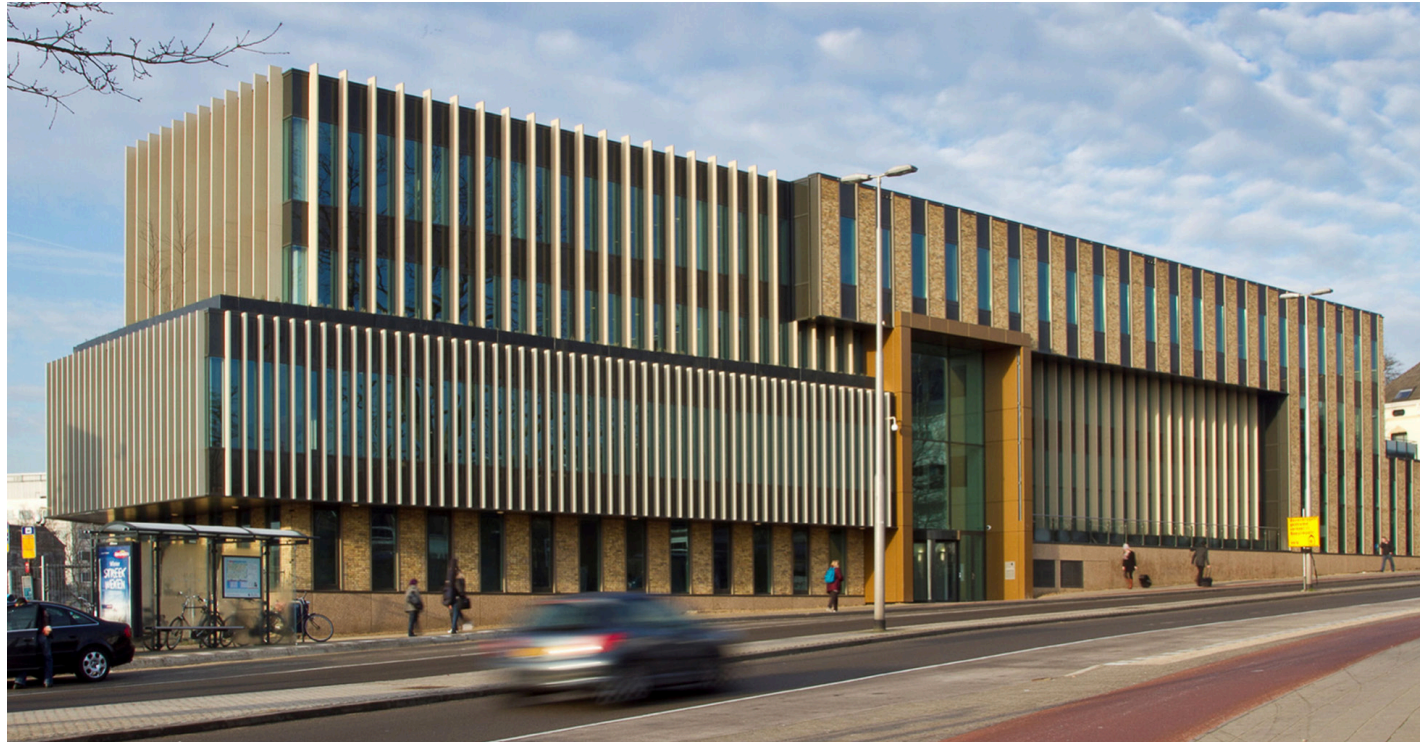
Kantoor met horizontale orientatie in de gevel
