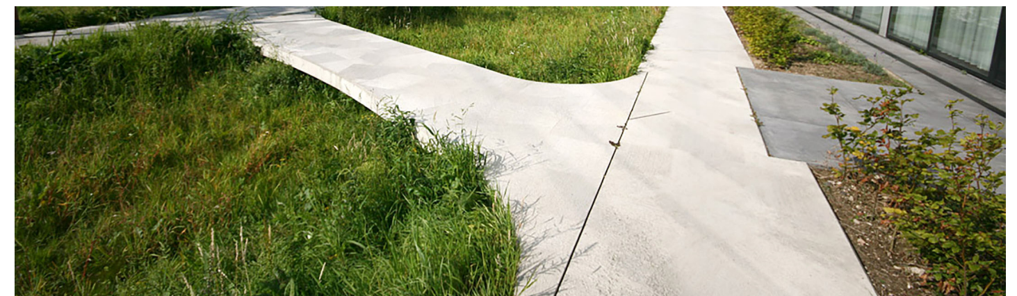
Quirijnpark, Tilburg - Gestort beton als wandelpaden door de vegetatie
