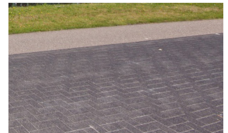
Rijbaan van betontegels met asfaltstrook voor fietsers
