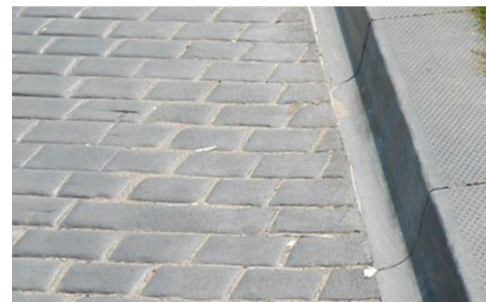
Gestort beton met print. Kleurstelling van de verharding is op elkaar afgestemd
