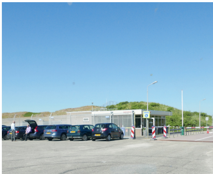
1> Controlepost bij de zuidelijke entree
