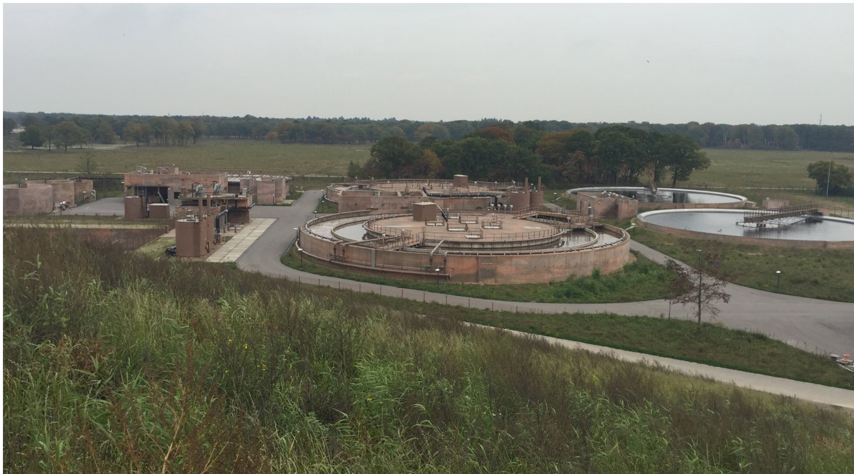
Waterzuivering, Hilversum - Alle gebouwen zijn met hetzelfde materiaal vormgegeven en vormen daardoor een ensemble
