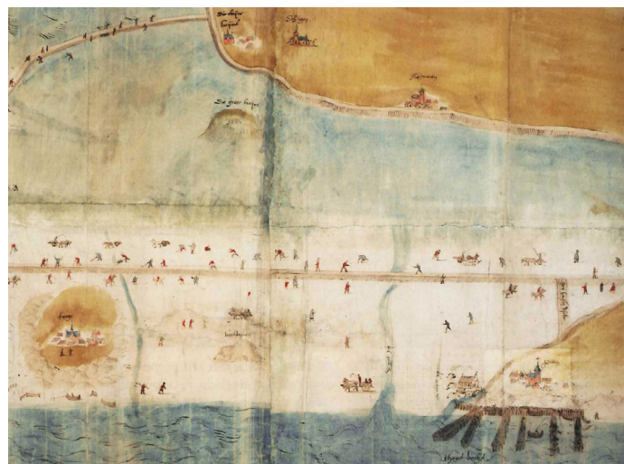
1596 - Aanleg van de Zijperzeedijk
