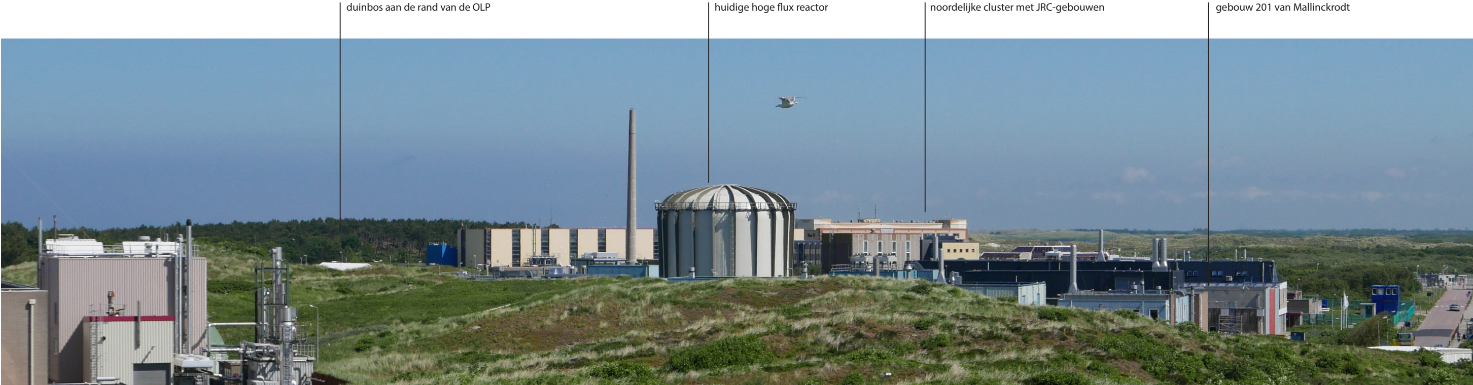
6. Oostelijke cluster met de HFR (erachter het noordelijke cluster)
