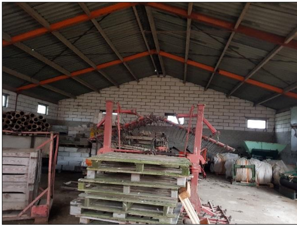
Figuur 5. Binnenkant loods in het noordwesten (plangebied 1)
