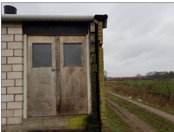
Figuur 14. Open spouwmuur in noordzijde stallencomplex (plangebied 1)
