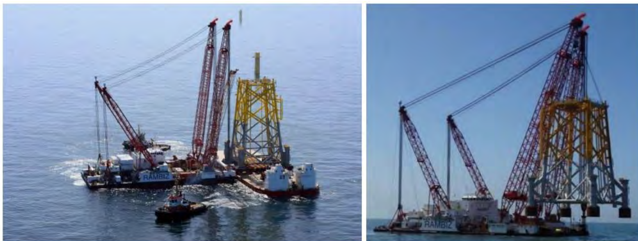
Figuur 5: Impressie van het plaatsen van het jacket.
