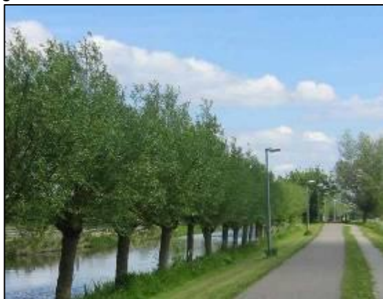
Afbeelding 23: Plaatsen van de lichtmast met de rug naar de vaar toe (bron : Haarsma, 2010).
