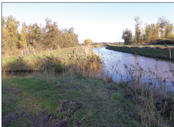
De Schans met het Zuiderafwateringskanaal.
