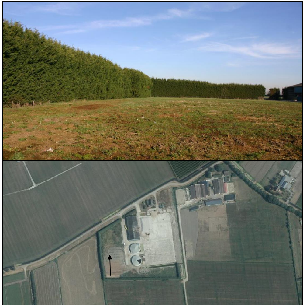
Figuur 4.7: Foto op het erf in noordelijke richting langs de coniferen haag
