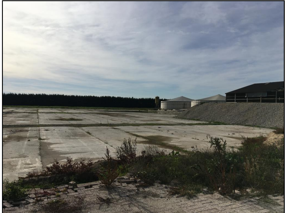
Alleen de putvloer resteert, rechts de 2 mestilo's en de loods.
