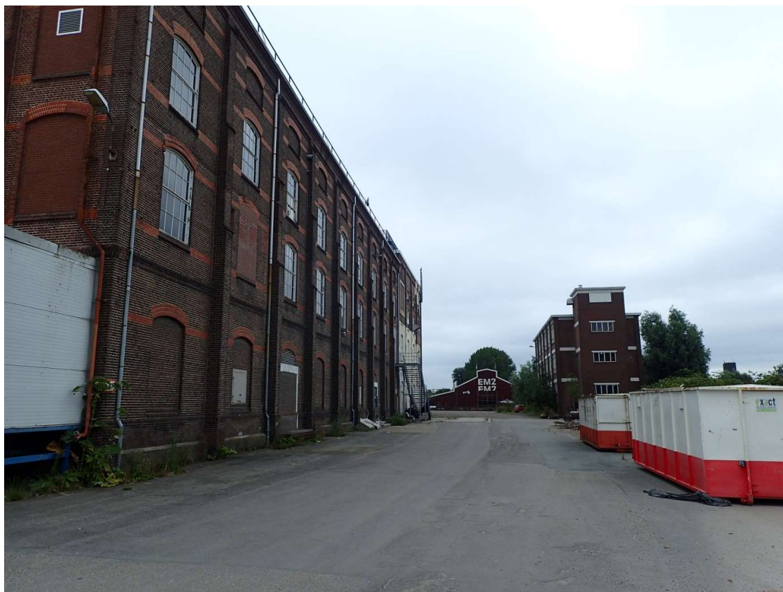
Figuur 32. Resterende bebouwing van de voormalige suikerfabriek (foto: RAAP, 17 juli 2019).
