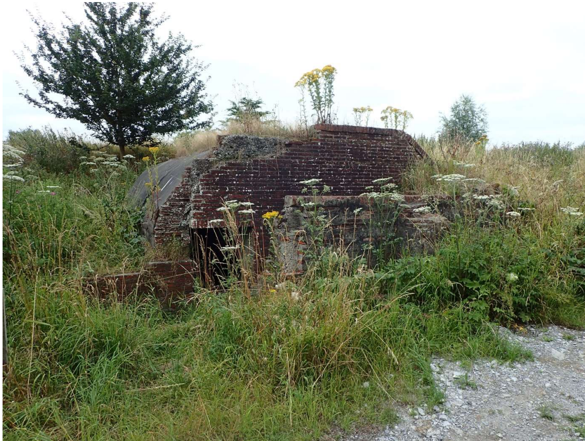
Figuur 57. Bakstenen bouwwerk in de Duitse verdedigingslinie, mogelijk een verblijf voor manschappen. Vóór de voorgevel staat een scherfmuur. Schuin ertegenover staat nog een soortgelijk gebouw (foto: RAAP, 17 juli 2019).
