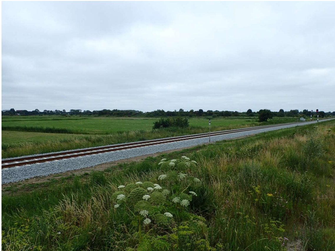
Figuur 52. Het landschap van het SuikerUnie-terrein is horizontaal én verticaal gelaagd: op de achtergrond en voorgrond de vloeivelden van de SuikerUnie, links het voormalige krekenlandschap dat in de late middeleeuwen is herverkaveld en daar doorheen de spoorlijn (foto: RAAP, 17 juli 2019).
