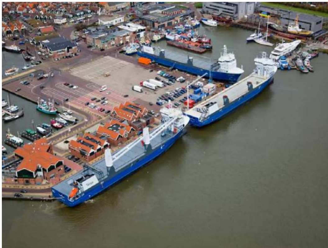
Figuur 1-1 Huidige haven van Urk in november 2013 (bron: Eindrapport verkenning buitendijkse maritieme servicehaven bij Urk van 2 oktober 2014)
