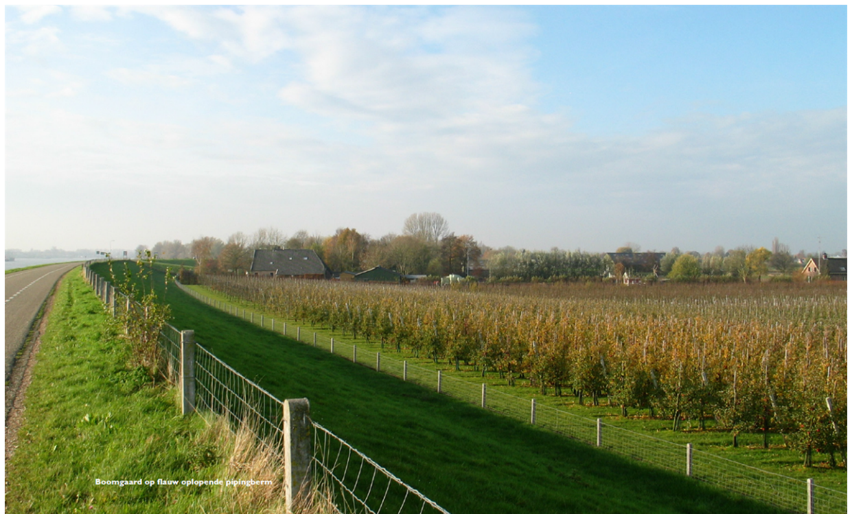
Figuur 5.9 Boomgaard op flauw oplopende pipingberm
