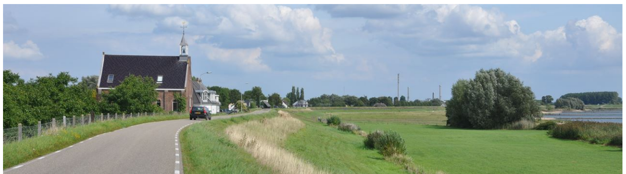
Figuur 1.1 Foto van de dijk
