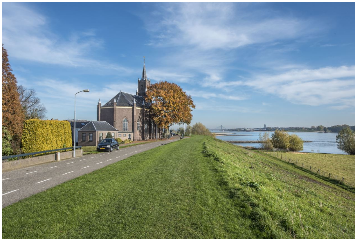
Figuur 3.3 Foto van de dijk
