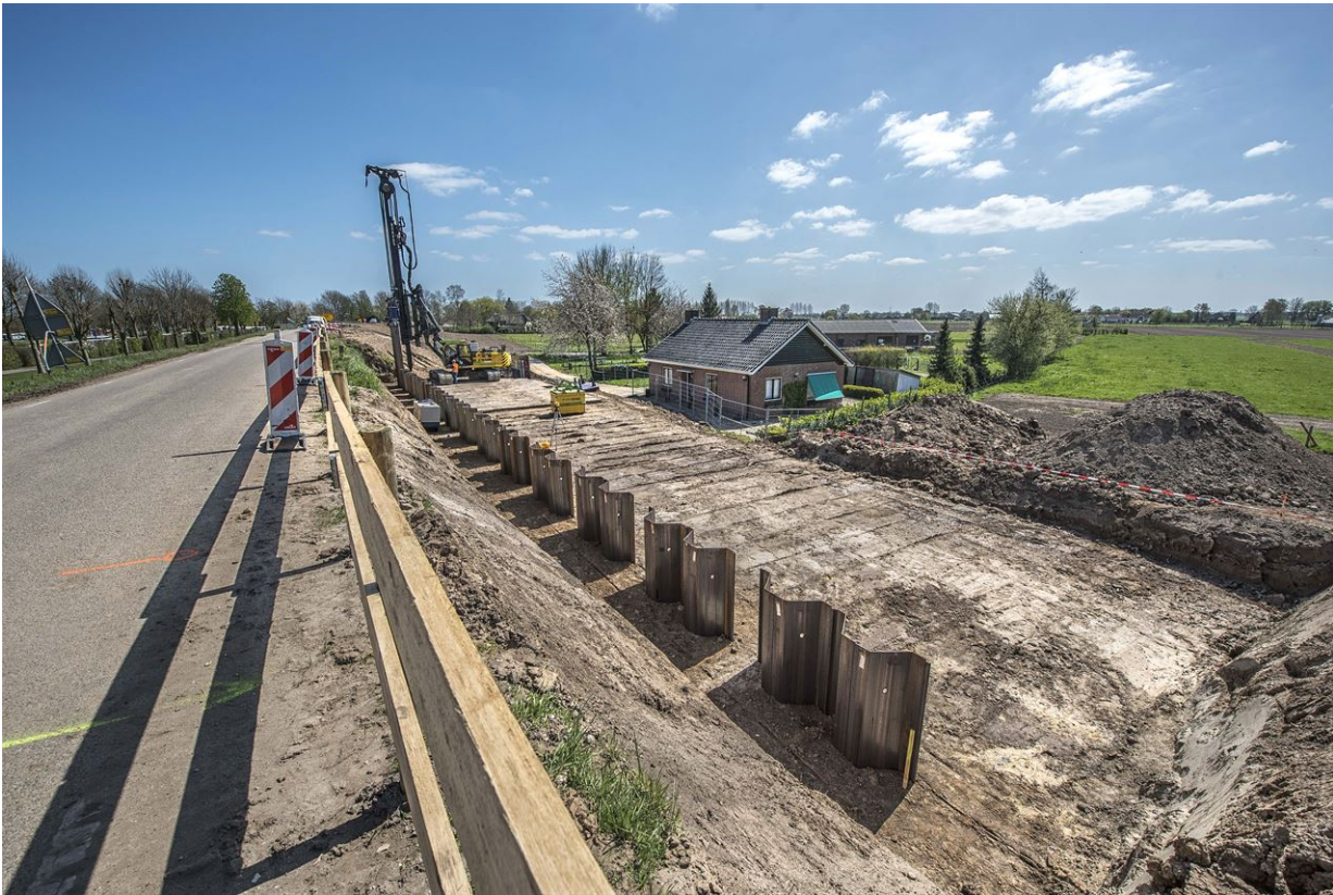
Figuur 4.24 Impressie werkzaamheden en materieel
