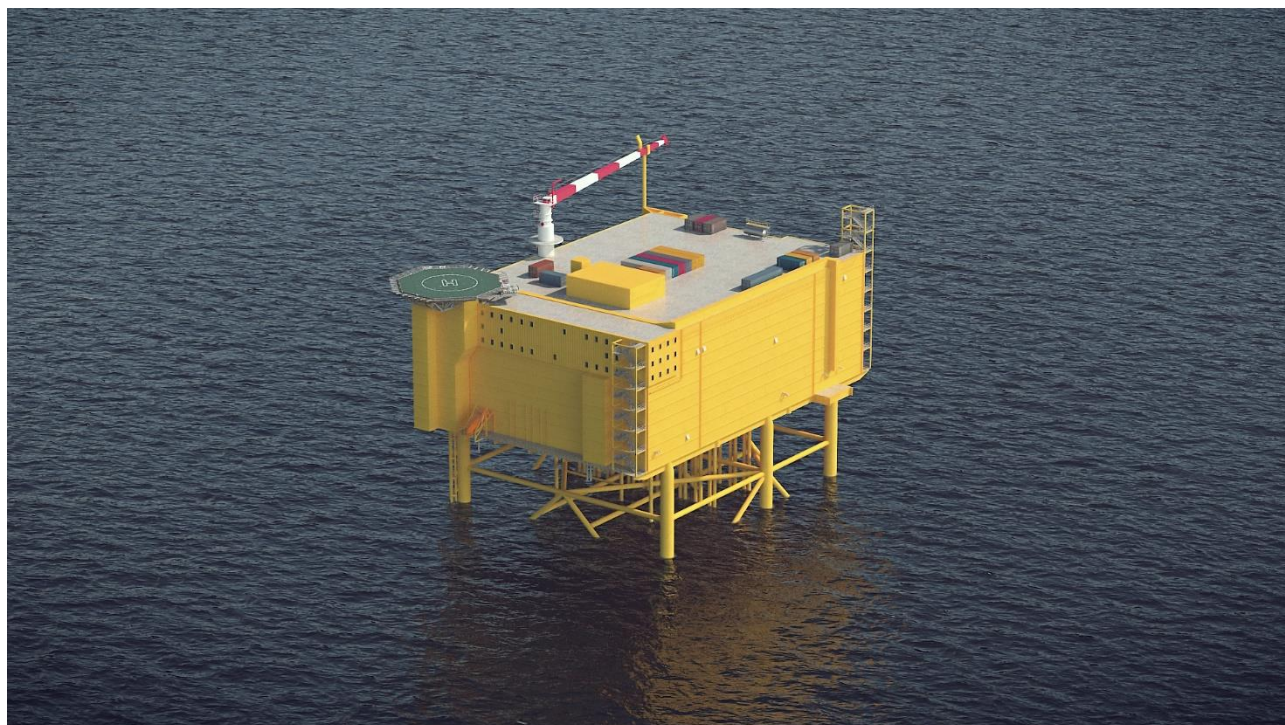
Figuur 1-3 Artist's impressions van een 2 GW platform voor IJmuiden Ver (met een stalen draagconstructie)
