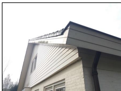
Figuur 9. Afwerking dak woning Spurkt 5a (datum foto: april 2018).
