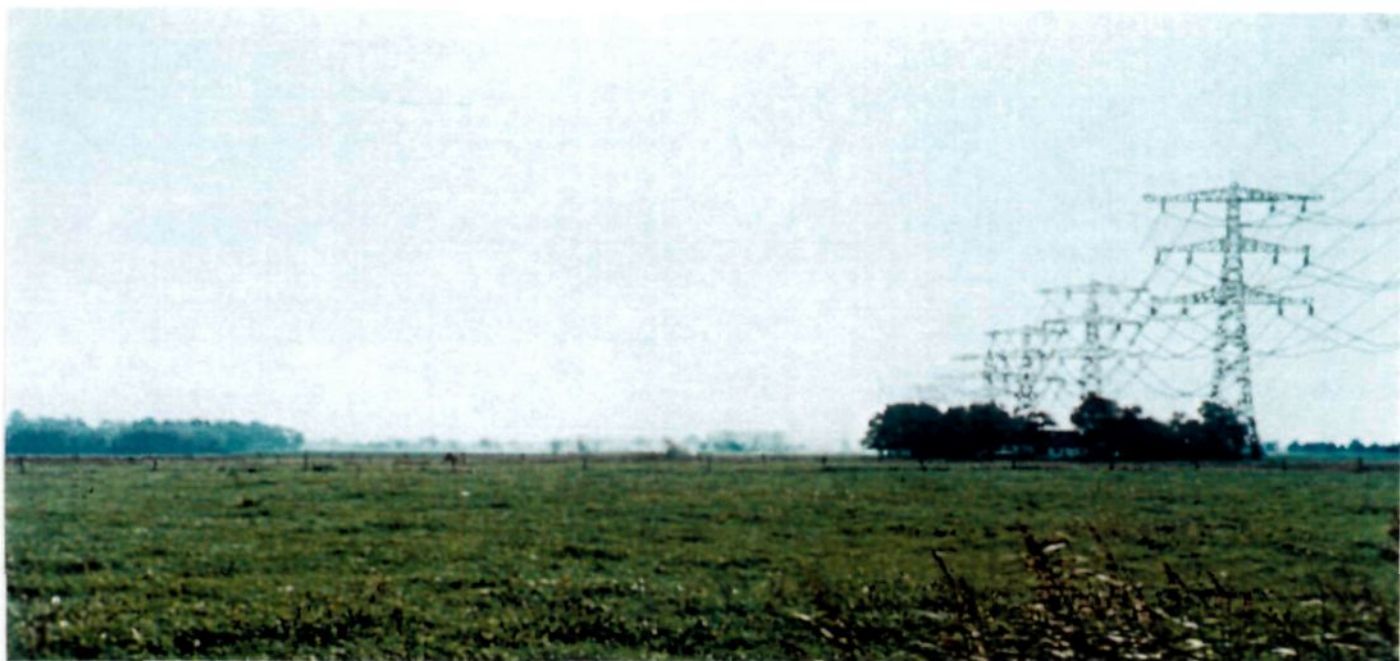
Fig. 6.7 380 kV combinatie op één mast
