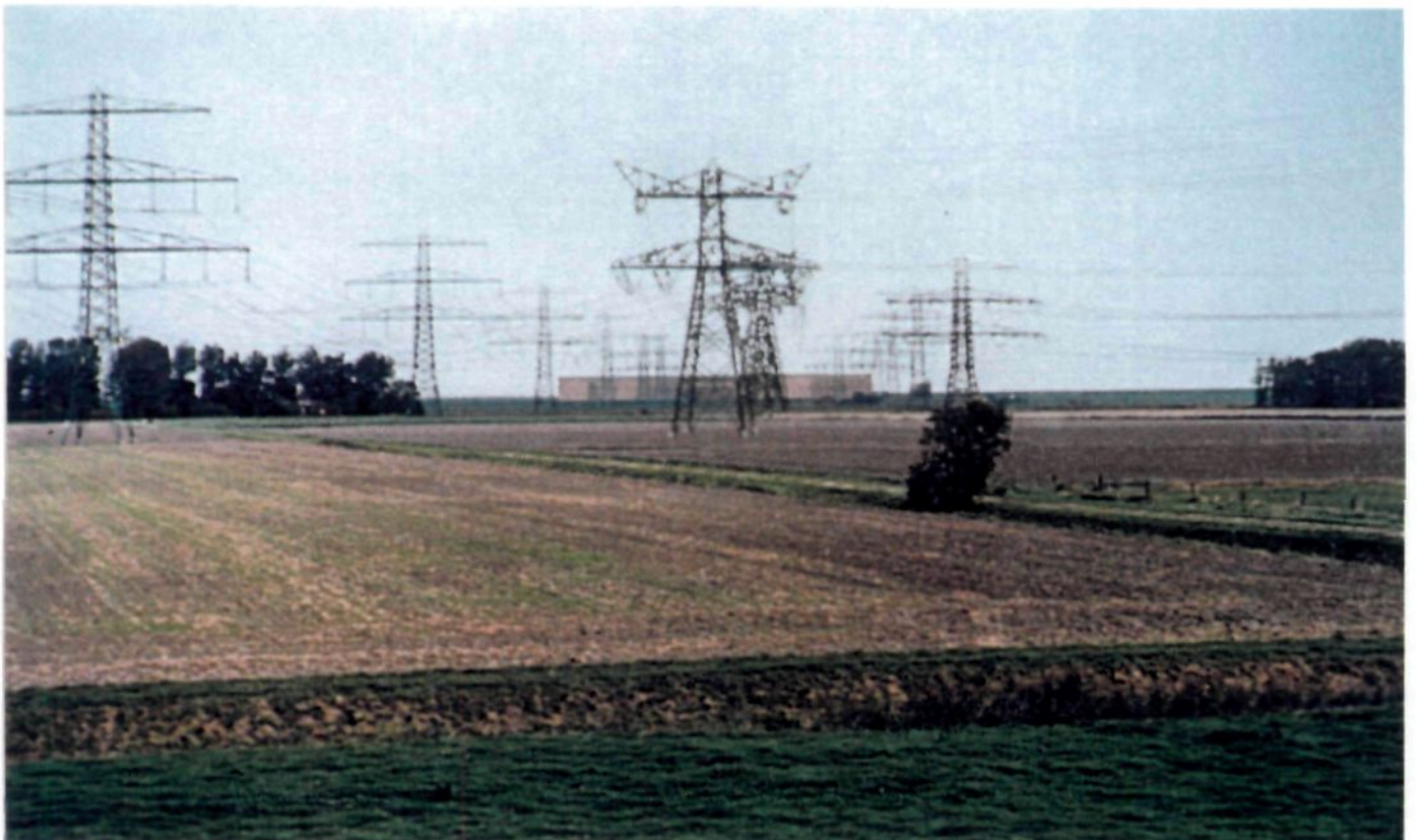
Fig. 6.16 380 kV-lijn naast 220 kV-lijn; overkruising van 220 kV-lijn naar Vierverlaten
