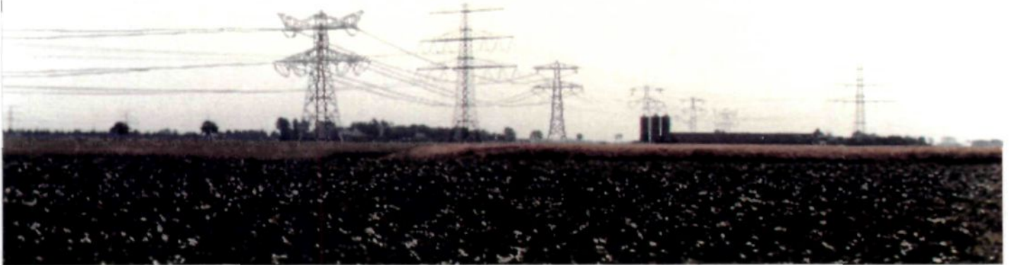
Fig. 6.14 380 kV-lijn naast 220 kV-lijn naar Vierverlaten; nabij boerderij 'de Eemshoeve'
