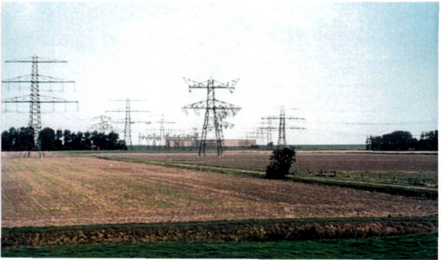
Fig. 6.17 Stationsnadering; 220 kV-lijn naar Vierverlaten op portaalmasten
