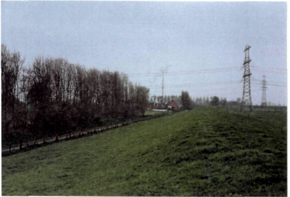
Fig. 5.3 Zicht langs de dijk tussen gem. Hefshuizen en gem. Delfzijl in westelijke richting. Op de voorgrond de 220 kV lijn naar Weiwerd, op de achtergrond de 220 kV lijn naar Vierverlaten.
