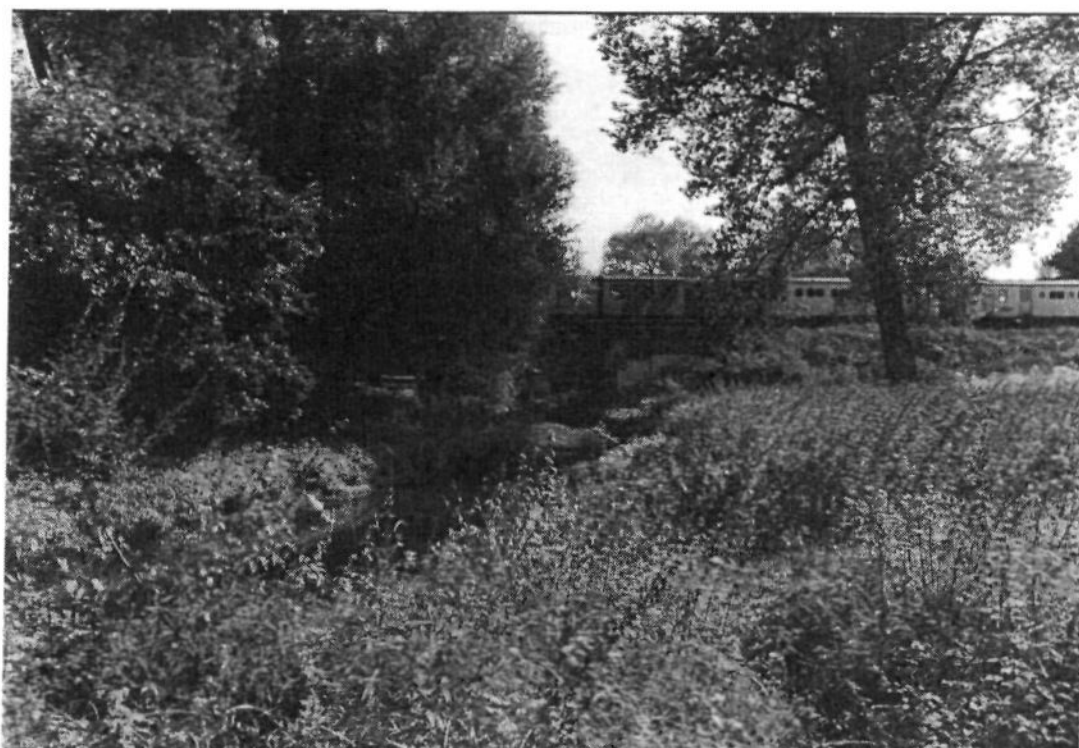
figuur 4.2 spoorviaduct Swalmdal
