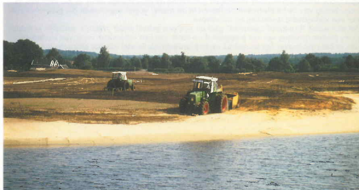
Foto 2: Intensieve werkzaamheden bij de aanleg van een golfbaan Foto: G. Jol
