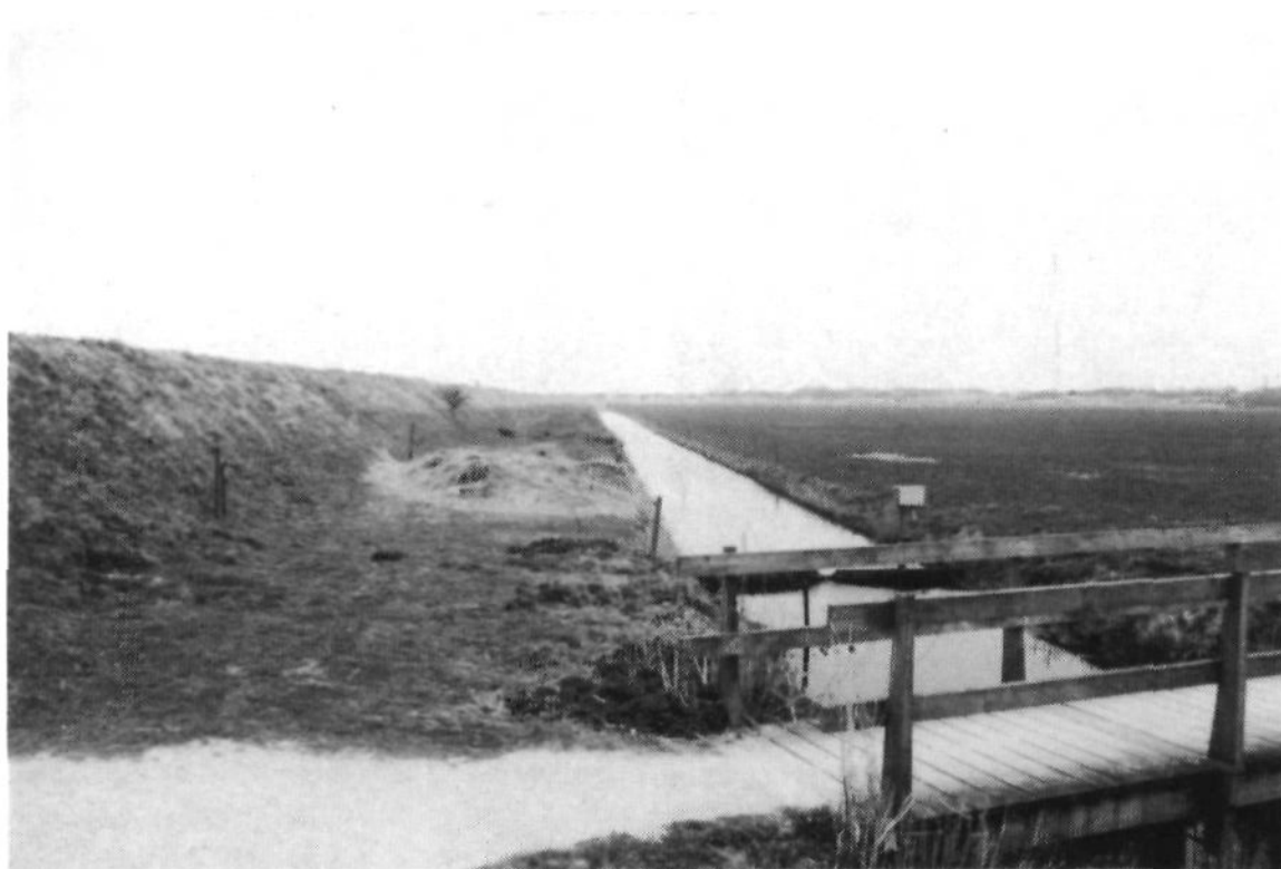
Foto 4: de afvoersloot, van waaruit het water in de Westerplas zal worden gepompt met behulp van een gemaaltje.
