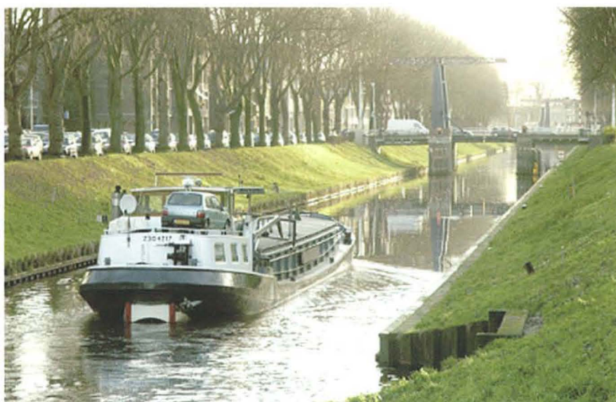
Een vrachtschip op de Zuid-Willemsvaart ter hoogte van de Orthenbrug.
