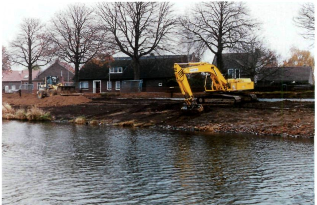
Na de hoogwaters van 1993 en 1995 zijn kaden aangelegd.
