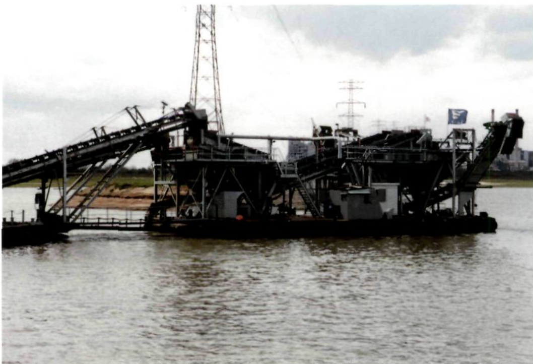
Scheidingsinstallatie voor delfstoffen
