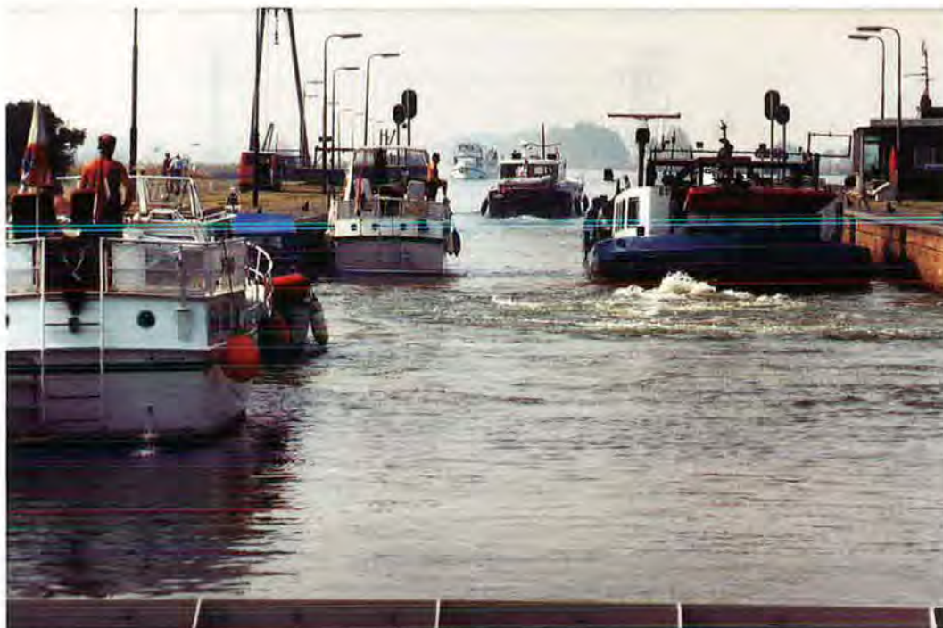
Sluis Maasbracht, recreatie- en beroepsvaart, Julianakanaal
