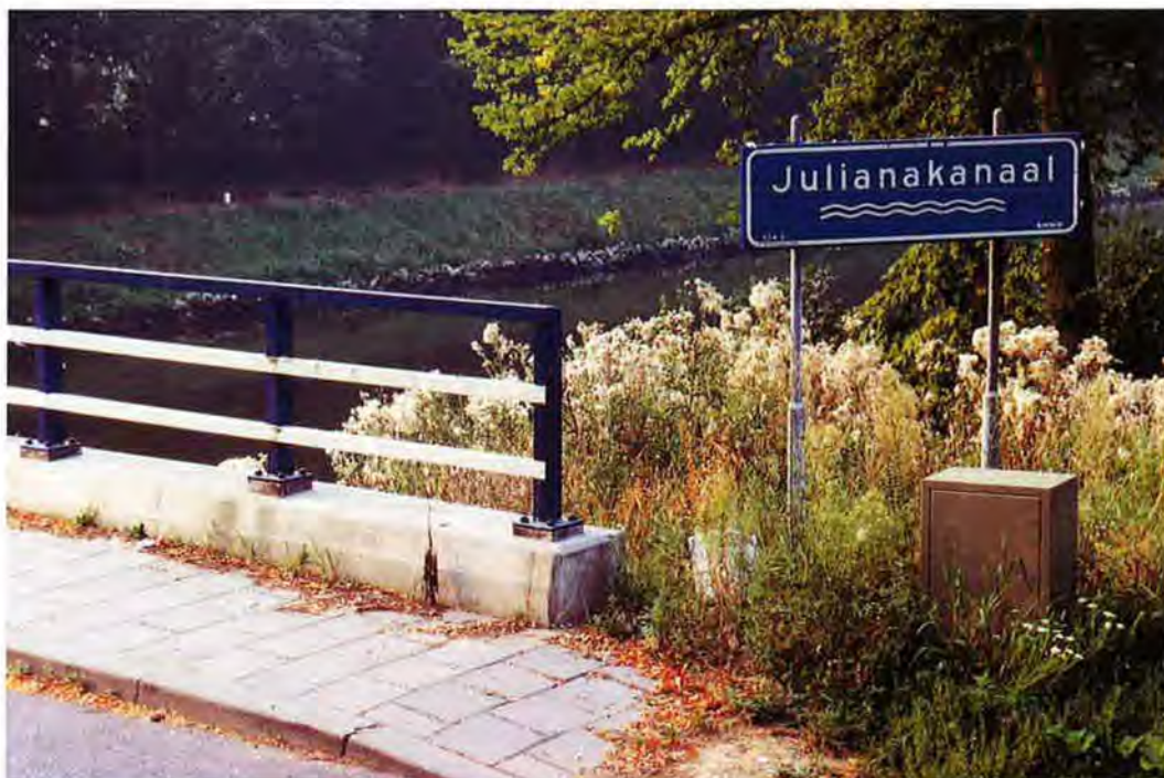
Brug over Julianakanaal bij Geulle
