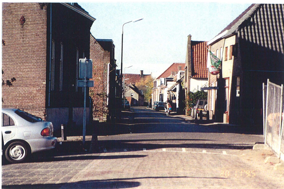
Figuur 4.5: Bebouwing weerszijden op de dijk in Lith (deelsectie 11)
