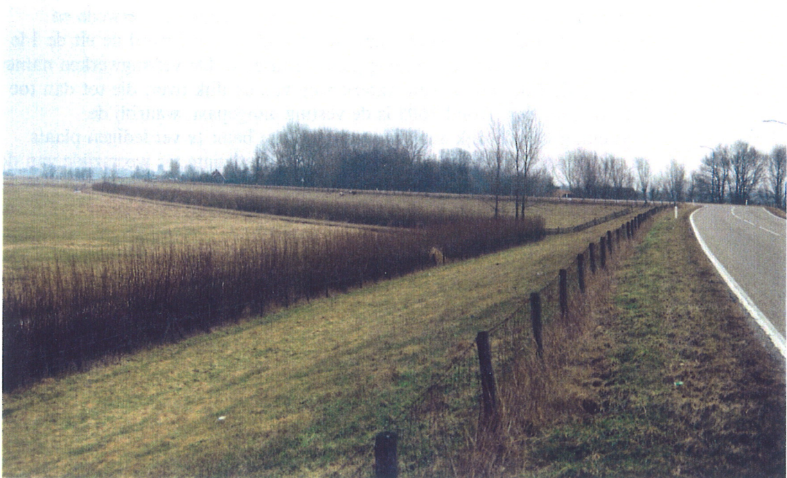
In de bocht (dp 1028-1032), gemarkeerd door een dietal populieren is langs de buitenteen van de dijk een griendstrook aanwezig.
