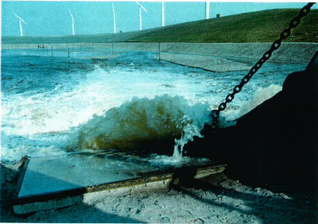
Figuur 5.8. Het vullen van een sedimentatiebekken.
