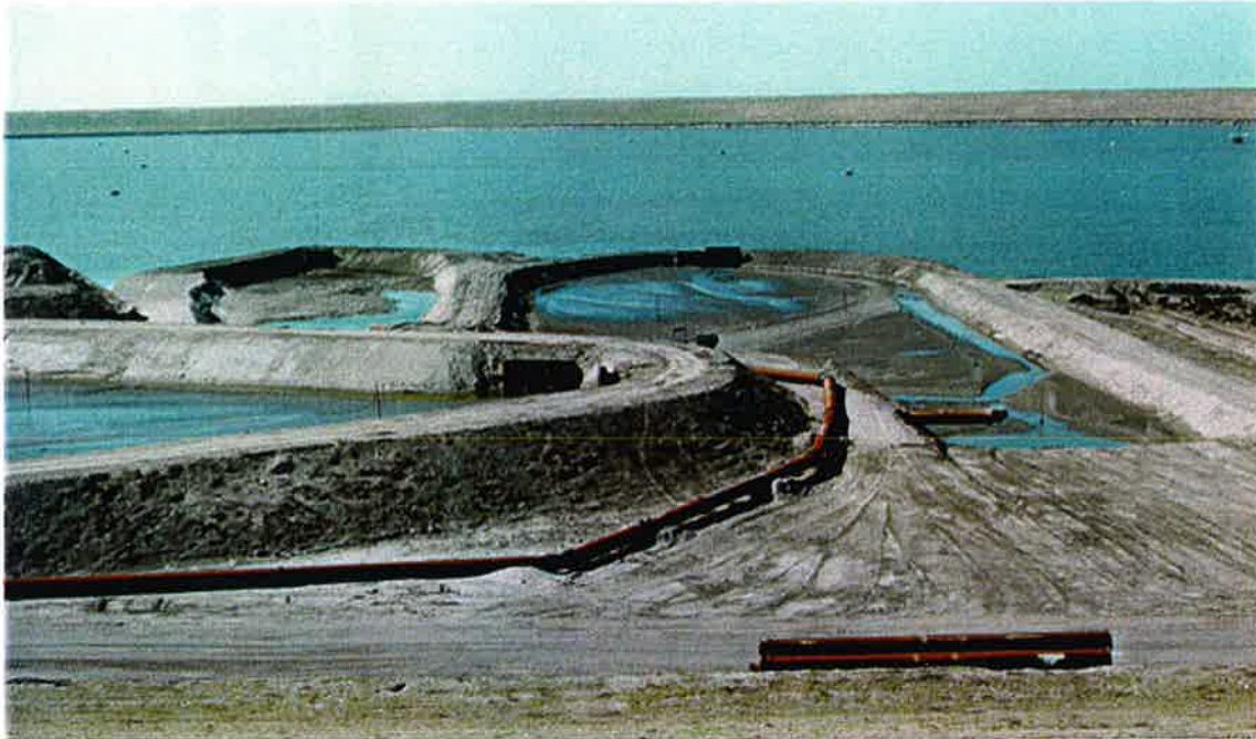
Figuur 5.7. Overzicht van sedimentatiebekkens. De in hoogte verstelbare overstorten van het ene bekken naar het andere en de overstorten naar de Slufter zijn duidelijk herkenbaar. De ringleiding dient om specie eventueel direct in een van de achterste sedimentatie bekkens te brengen.
