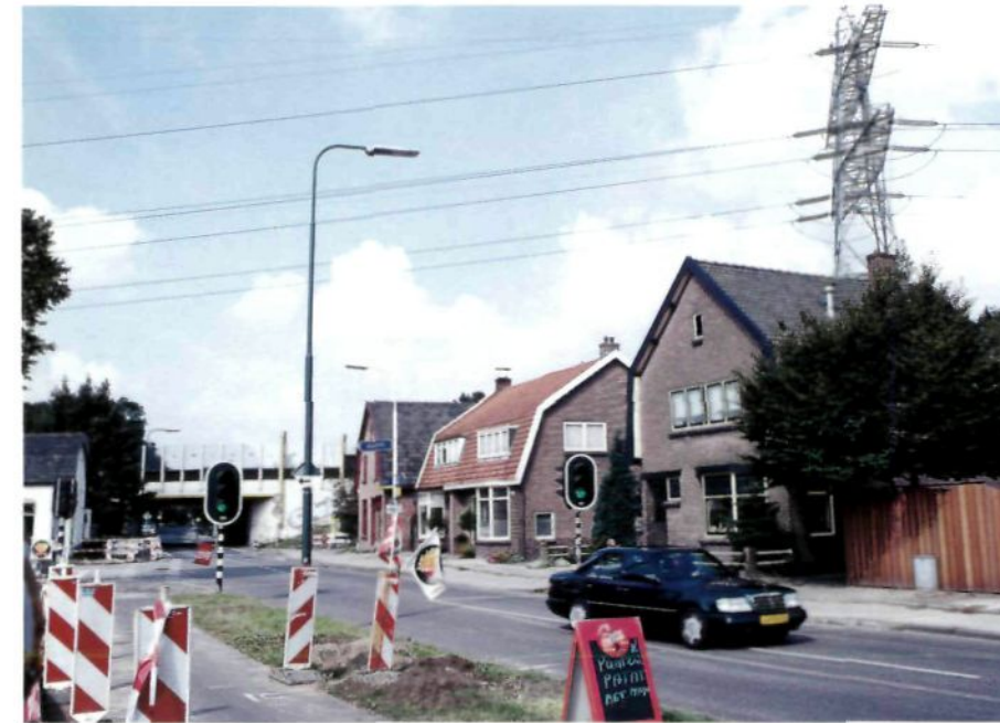
fig. 3.16 De hoogspanningsmast staat vlak langs de A12
