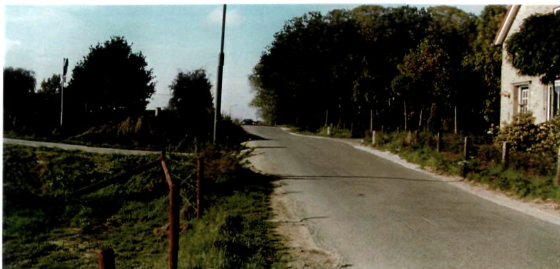
Dijkoprit van de openbare weg met aansluiting fietspad (kijkrichting: west)
