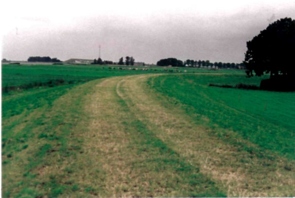
Figuur 4.2 Voorbeeld semi-verhard inspectiepad (Usseldijk)
