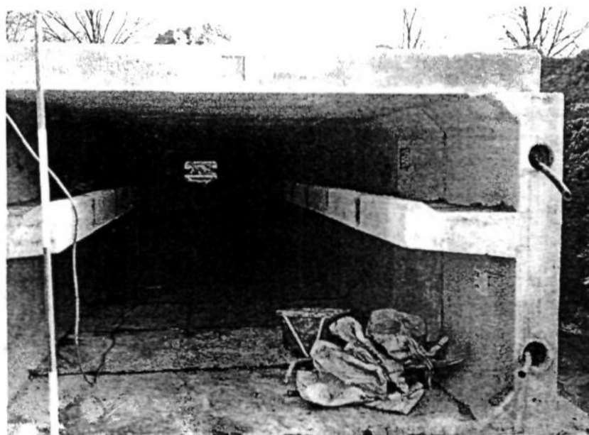
Foto [1.6.1] 3 Aanleg van een ecoduiker. De tunnel wordt opgebouwd uit geprefabriceerde elementen
