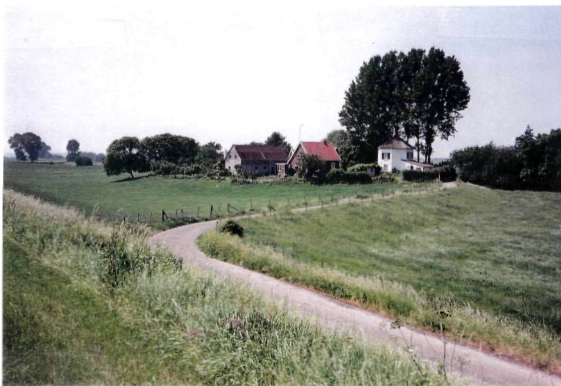
Buitendijkse bebouwing bij de Molendijk, Dp 26
