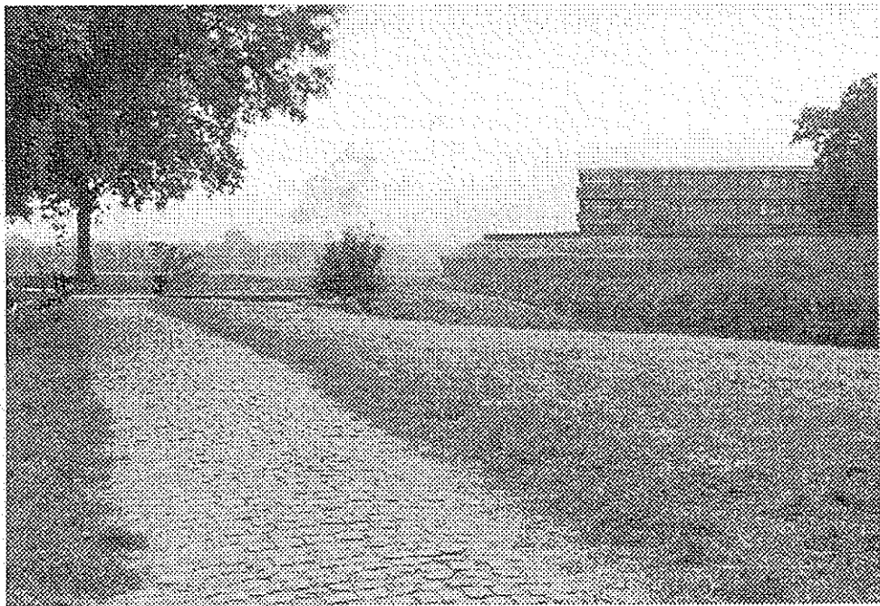
Foto 6: Gezicht van buiten de Dalempoort op de gerevêteerde wal bij het Verpleeghuis
