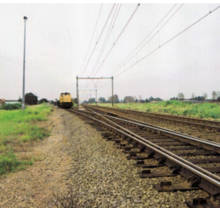
De aantakking op het hoofdspoor bij Eindewege
