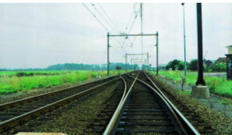
Aantakking op het hoofdspoor
