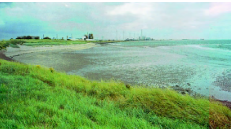
Naar verwachting zal de WCT zo'n 1,5 miljoen containers per jaar verwerken
