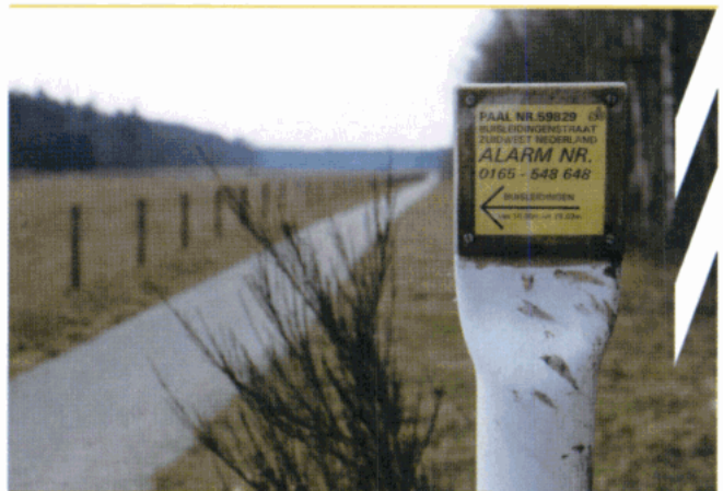
Buiseleidingenstraat ten oosten van Bergen op Zoom
