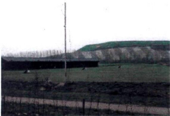
Foto 5: Stortterrein Gulbergen en Golfbaan (zicht op stort vanuit oostelijke richting)
