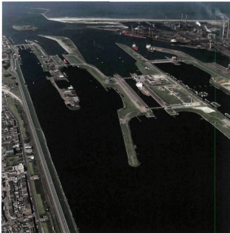
..... Overzicht van het sluizencomplex IJmuiden
