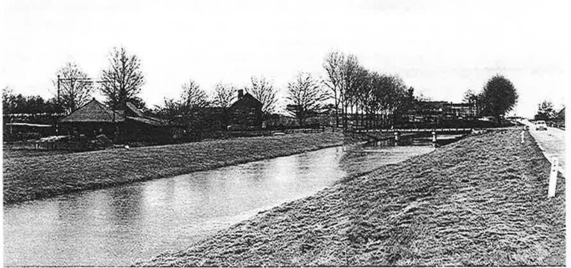
Hollandse dijk en sluis; Uithoorn/Bovenkerkerpolder.
