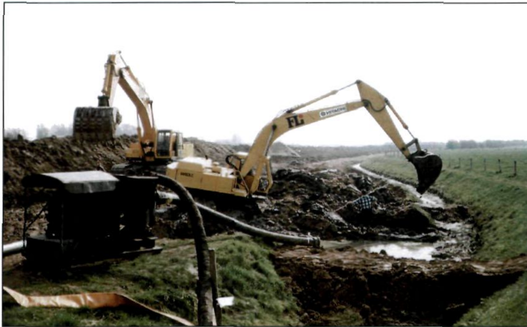
Foto 5.1. Dijkverbetering van de bestaande Pleijdijk in uitvoering (1991).
