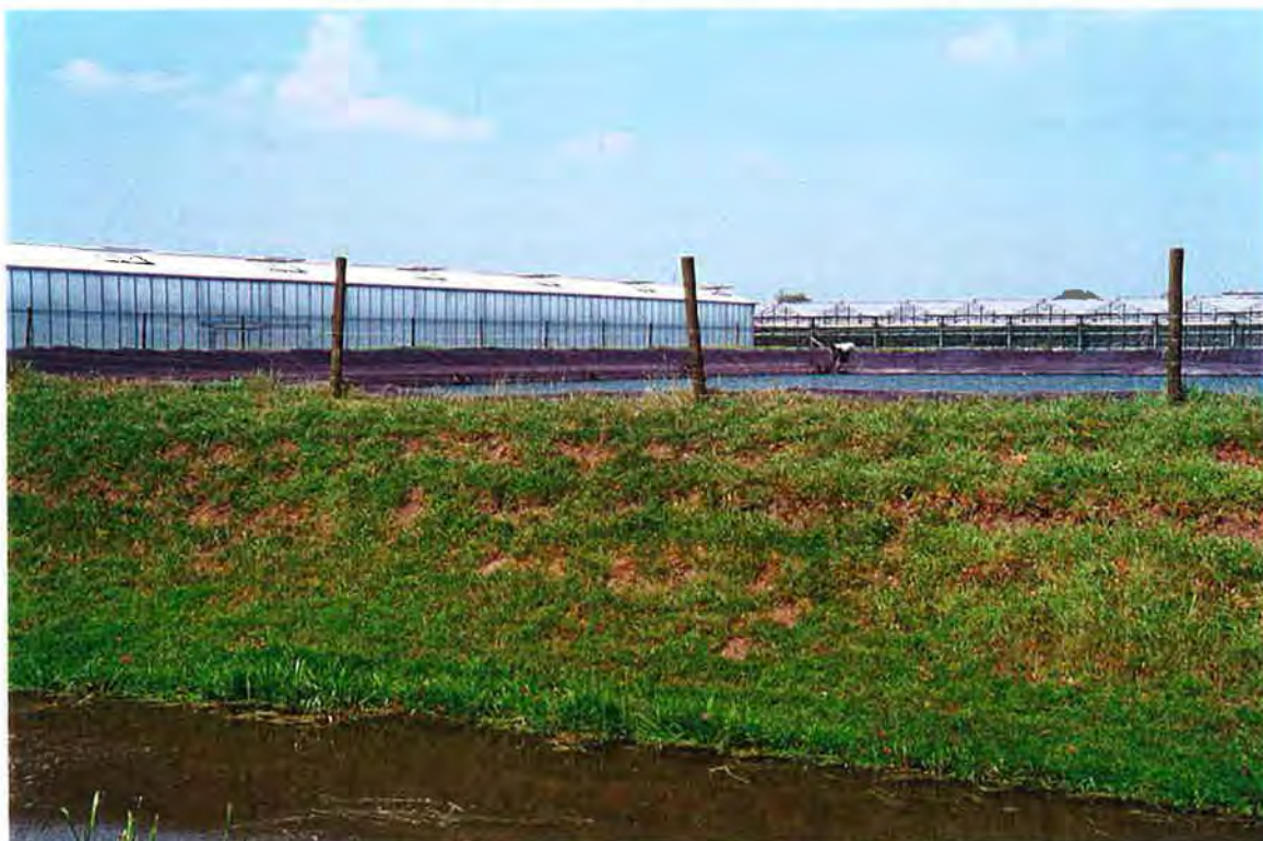
Afbeelding 4.2 Een gietwaterbekken met een grasmat op de ringdijk
