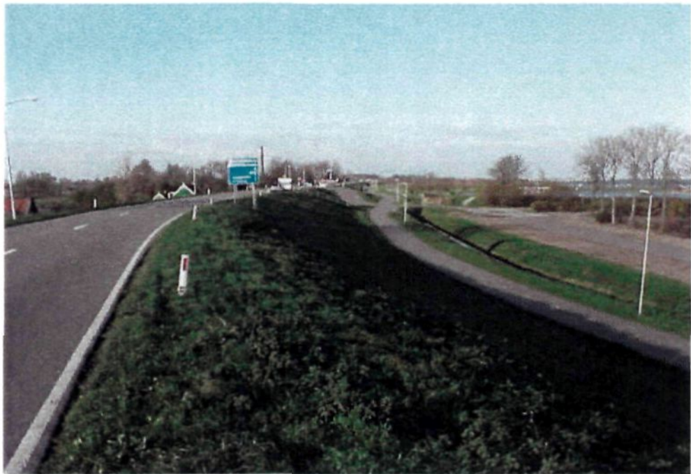
Figuur 3.2 Weg en fietspad op en langs de Oosterdijk VNK
