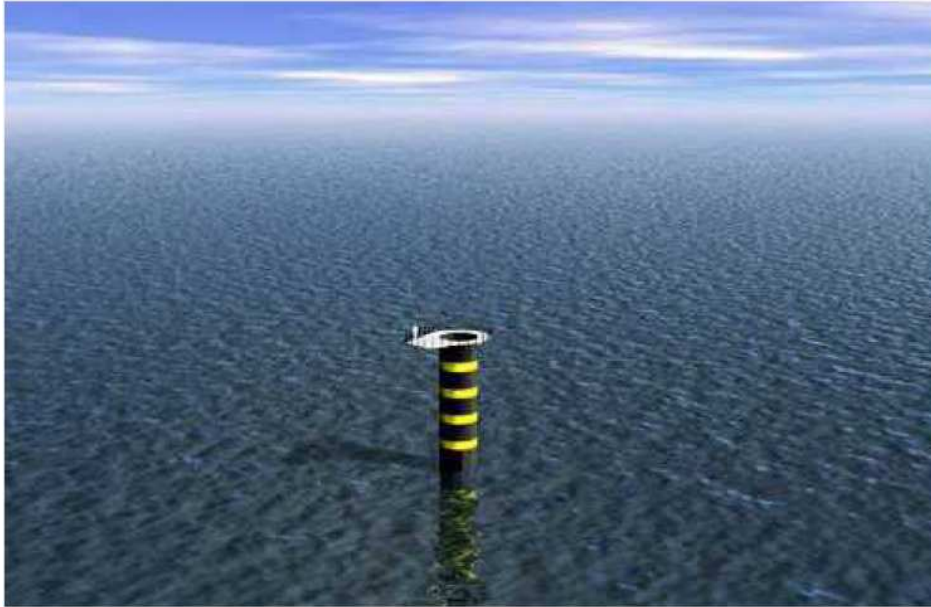
Figuur 4.16 Monopaal met transitiestuk geplaatst in zee
