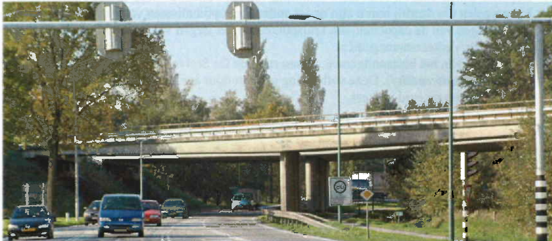
Viaduct A67 over de N284 ter hoogte van Eersel/Duizel
