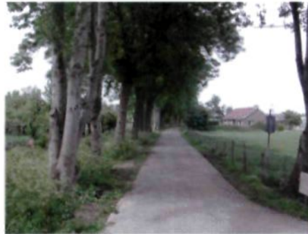
Fietspad over de oude grens
