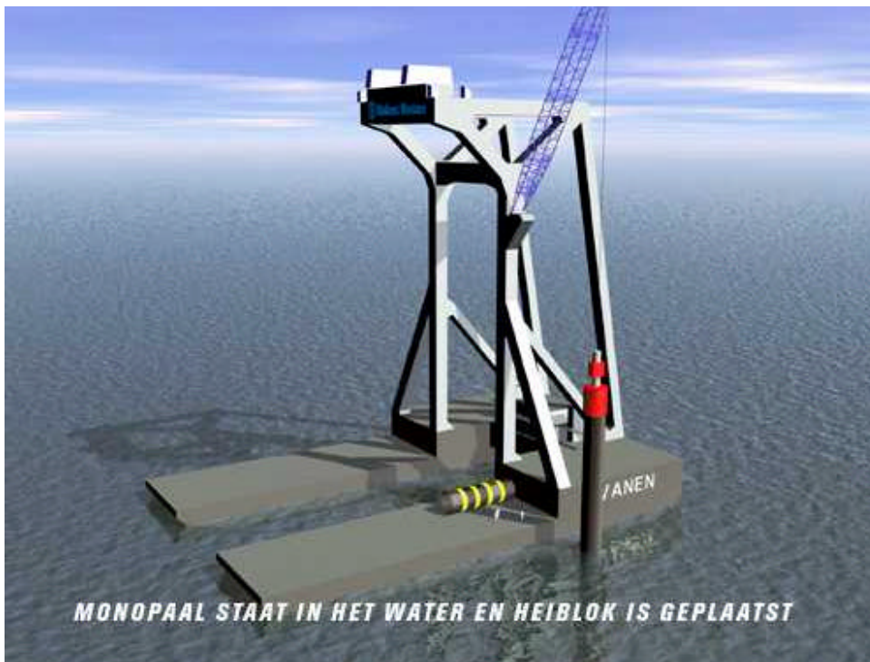
Figuur 4.6 Monopaal staat in het water en heiblok is geplaatst.
