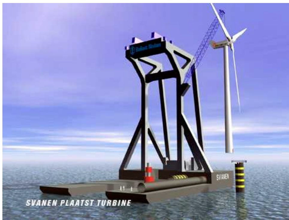
Figuur 4.10 Installatievaartuig 'de Svanen' plaatst turbine.
