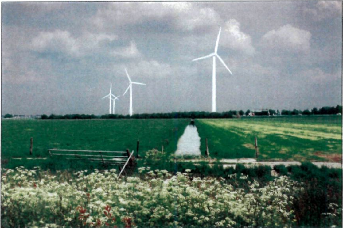
Woerden zuid-west lijnopstelling gezien vanaf de Molendijk, Waarder in oostelijke richting
