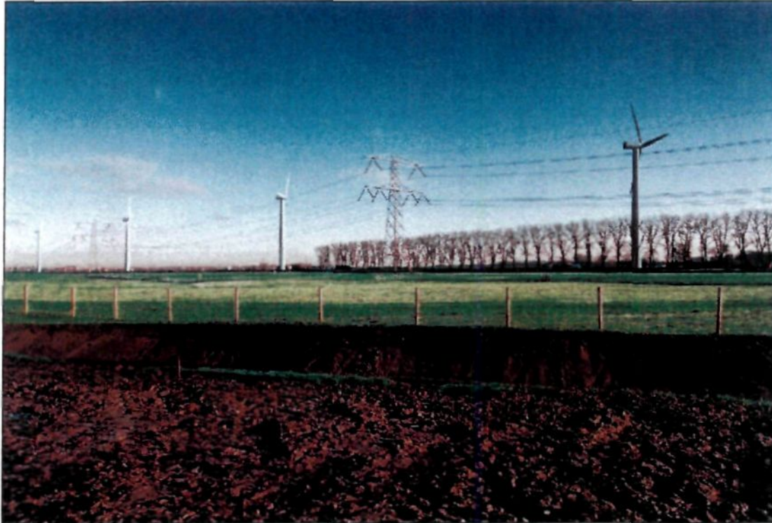
Lijnopstelling Breukelen noord gezien vanuit Nieuwer Ter Aa in oostelijke richting
