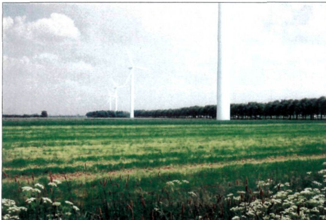
Lijnopstelling Harmelen zuid-oost gezien vanaf de Kerkweg in oostelijke richting
