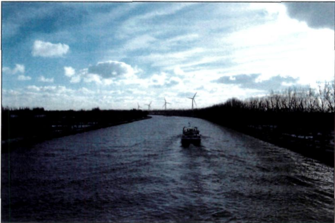
Zuidelijke Ijopstelling Breukelen vanaf brug Amsterdam Rijnkanaal
