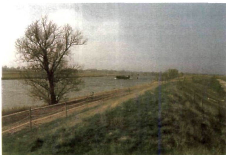
Figuur 4.1.2 Huidige situatie aan de zuidzijde van de hoogwatergeul
