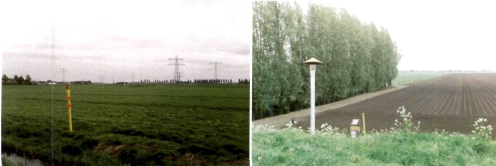
Figuur 7. Leidingtracés. Op de voorgrond de typerende aanduidingen van bestaande leidingtracés in het veld.
