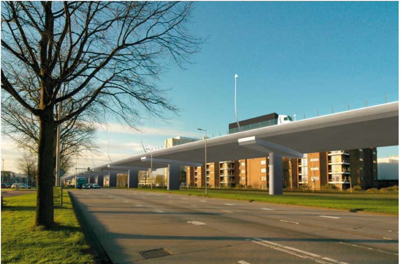
Afbeelding 3: Langs de Basisweg wordt de Westrandweg op een viaduct aangelegd.
