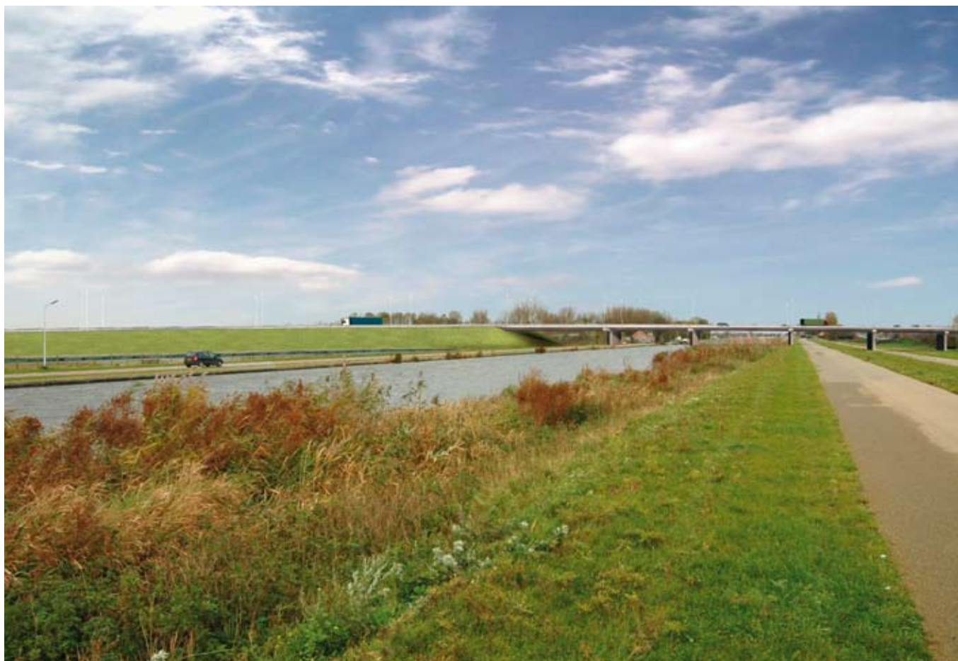
Afbeelding 5: Zicht vanaf Lijnderdijk oostzijde op het toekomstige viaduct over de Ringvaart Haarlemmermeer.
