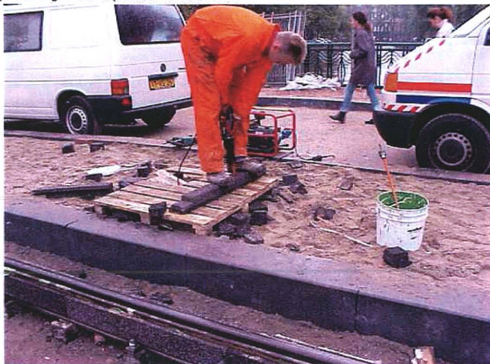
Montage van zijprofielen op brug Herengracht 4 oktober 2000 Op maat zagen van de profielen 4 oktober 2000
