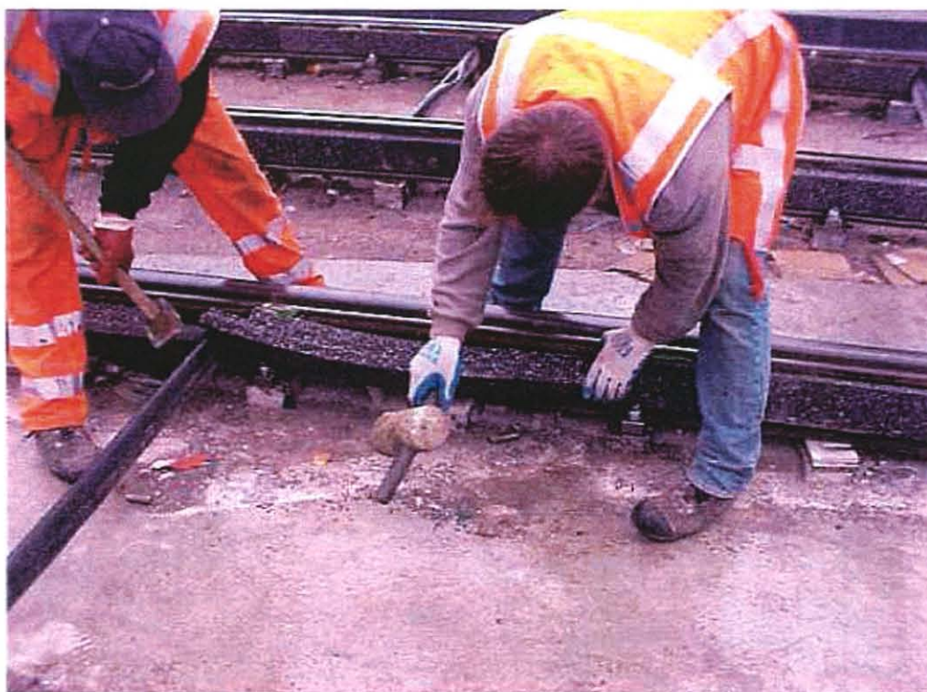
Montage van zijprofielen op brug Herengracht 4 oktober 2000 Op maat zagen van de profielen 4 oktober 2000
