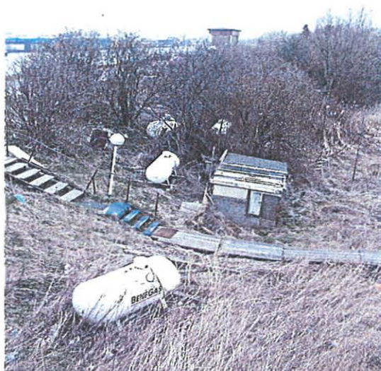
Foto 8: Zuiderzeedijk ter hoogte van nr 128
