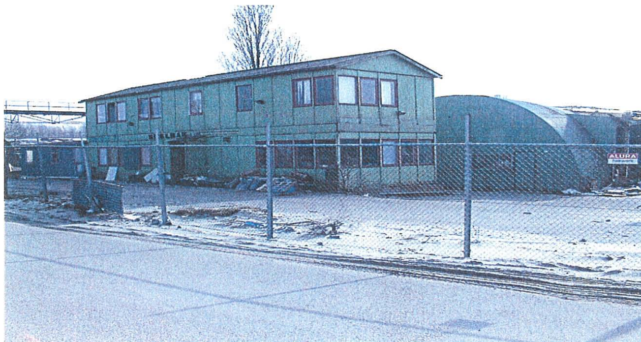
Foto 18: Voormalig kantoor Snelbak Zuiderijdk
