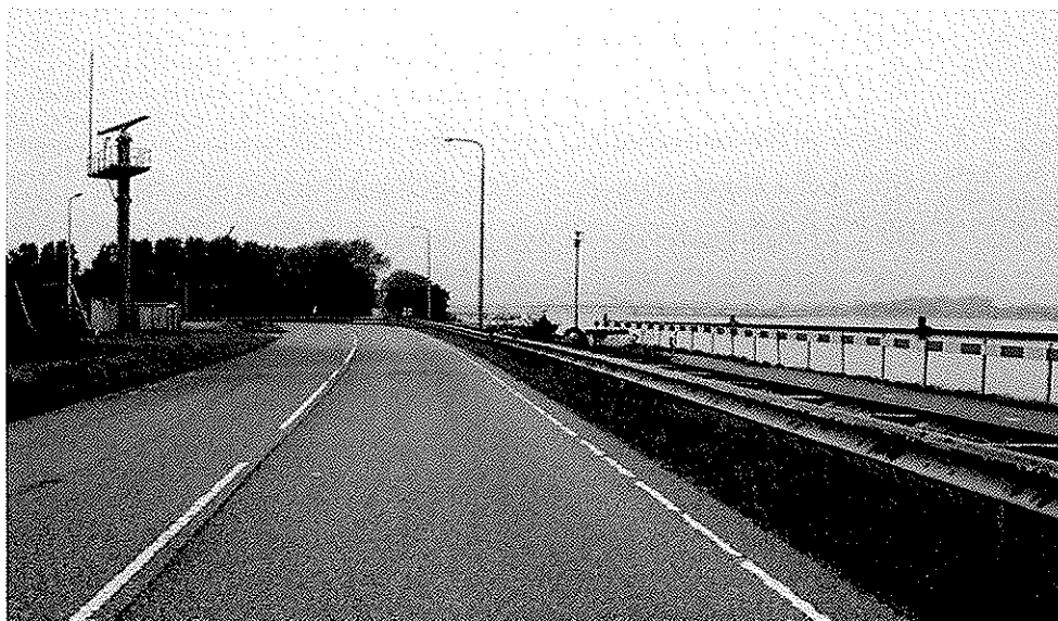
Foto 1 Oever aan de noordzijde van het Zeeburgereiland ter hoogte van de Zeeburgertunnel
