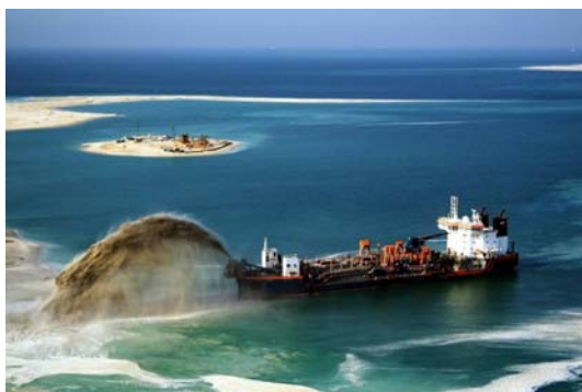
Figuur 5.3: Opspuiten van het zand
