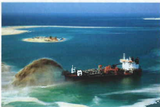
Figuur 5.3: Opspuiten van het zand
