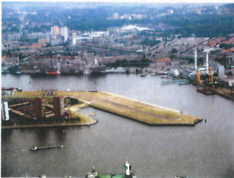
Figuur 1: Rivierkwartier, de braakliggende locatie
