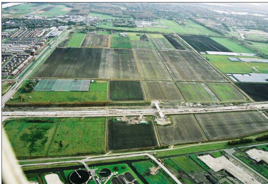
Luchtfoto "Wilderszijde" (zicht vanaf Berkel en Rodenrijs)
